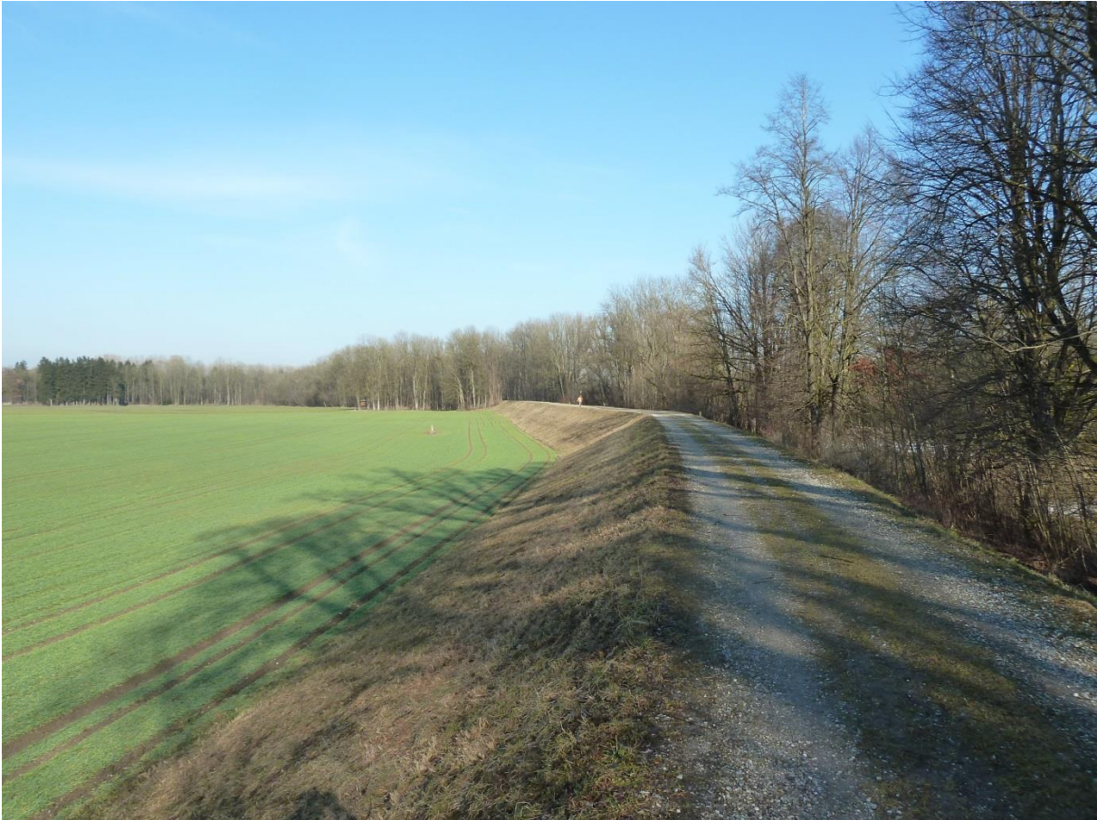
Im nördlichen Deichabschnitt haben die Erdarbeiten begonnen
